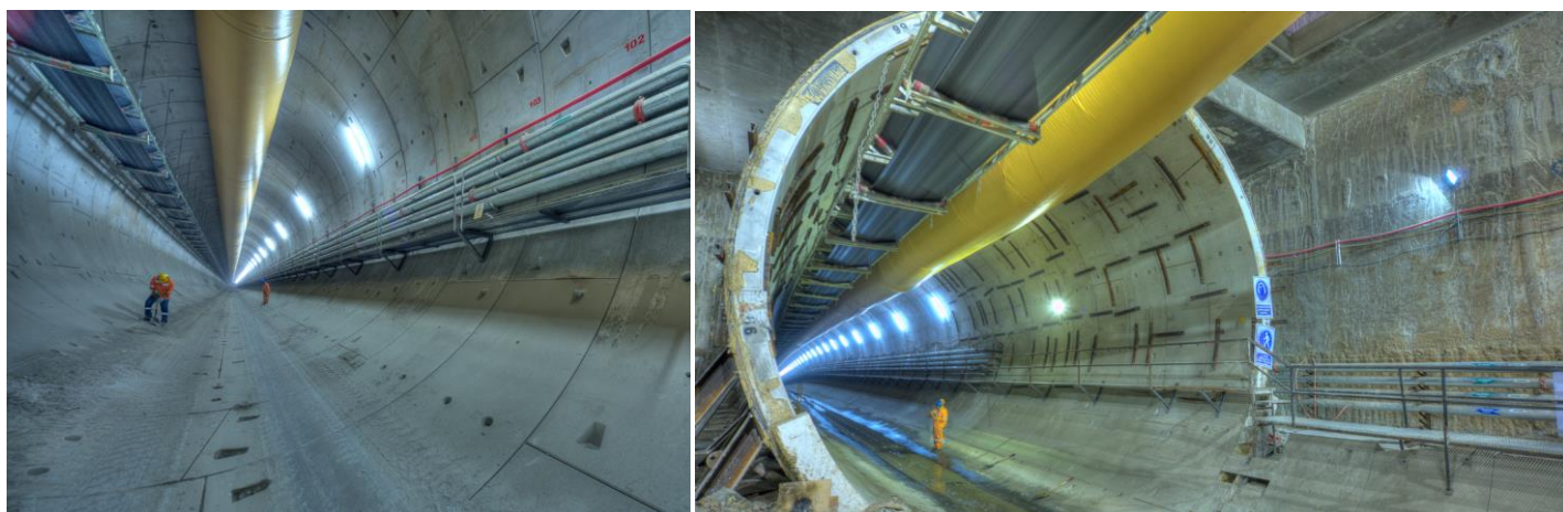
Fotos: Túnel estación El Labrador – estación Jipijapa
