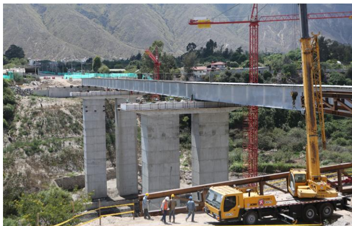
Foto: Construcción puente de Los Pájaros
