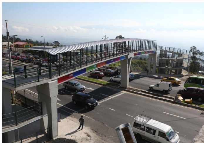
Foto: Puente peatonal Ruta Viva
