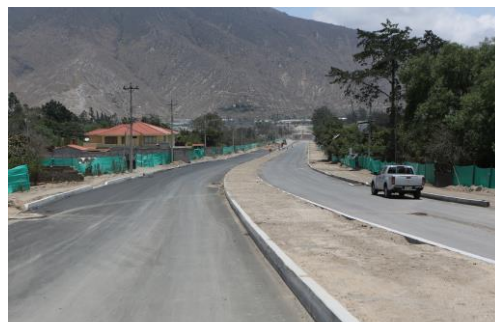
Foto: Prolongación Simón Bolívar
