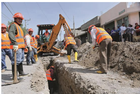
Foto: Alcantarillado y conexión de tuberías para proveer servicios de agua potable
