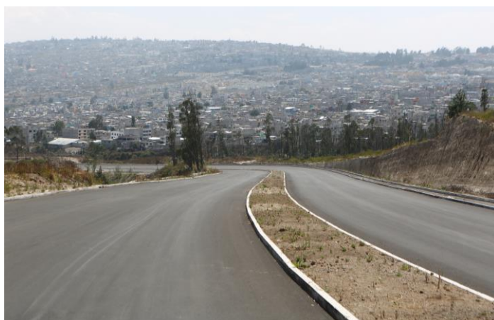
Foto: Prolongación de la Av. Simón Bolívar
