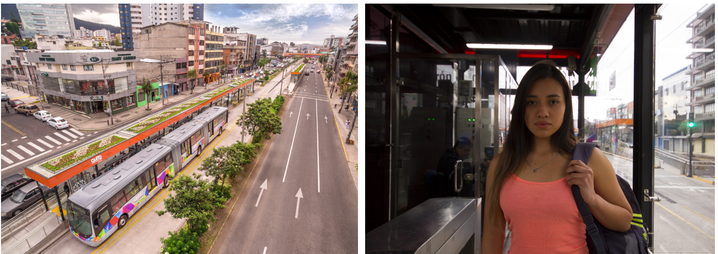
Foto: Nuevas estaciones del Sistema Trolebús
