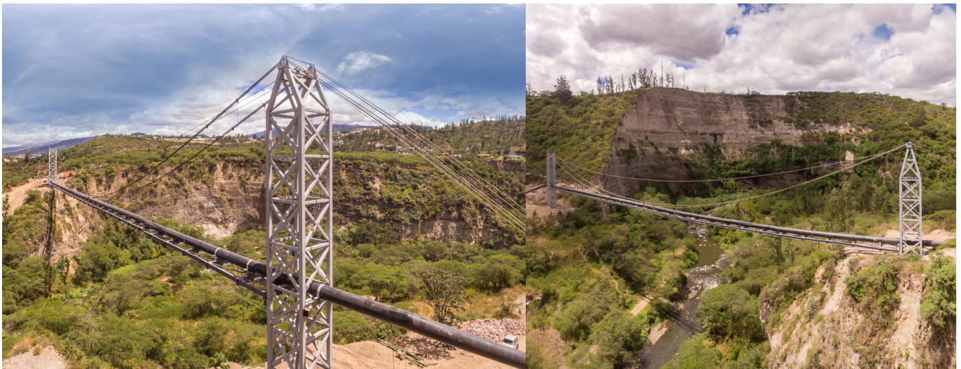
Fotos: Pasos elevados de agua
