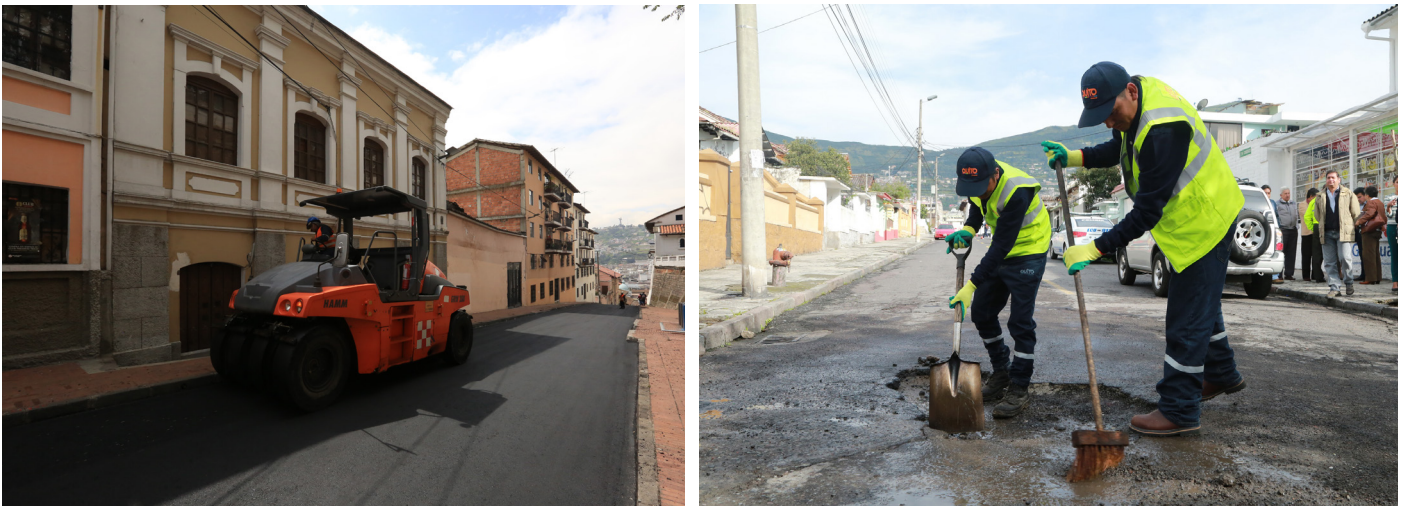
Foto: Programa de Rehabilitación y Mantenimiento Vial
